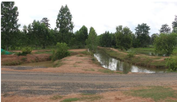
ภาพที่ 1.1.5 คลองส่งน้ำแบบคลองดิน
