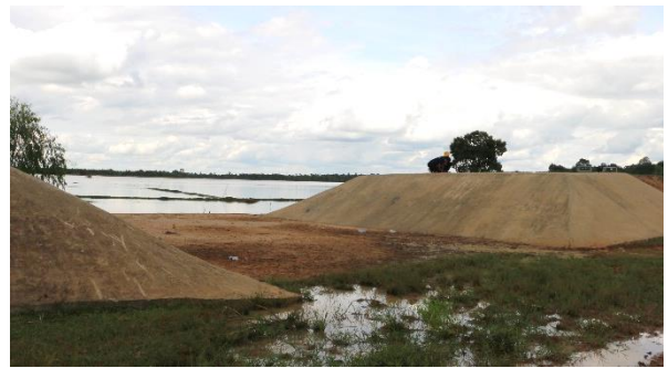
ภาพที่ 1.1.6 ฝายน้ำล้นจากอ่างเก็บน้ำ สตึงทะเลงายด้านท้ายอ่าง
