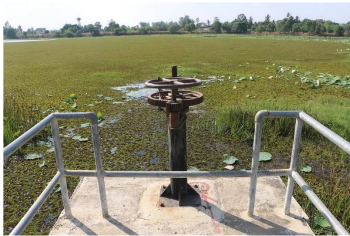
ภาพที่ 1.14.2 มีประตูเปิด-ปิดน้ำ สภาพใช้งานได้ปกติ
