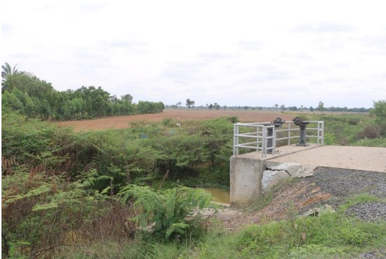
ภาพที่ 1.15.2-1.15.3 มีประตูเปิดปิดน้ำ สภาพใช้งานได้
