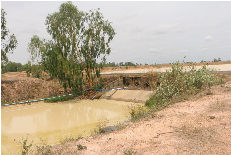
ภาพที่ 1.16.4 มีระบบน้ำเข้าเป็นท่อน้ำรับน้ำหลากจากบริเวณรอบ ๆ
