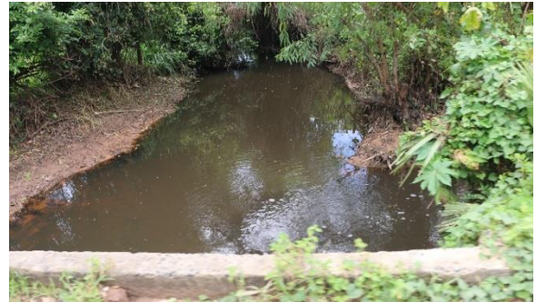
ภาพที่ 1.2.6 มีคลองส่งน้ำแบบคลองดิน
