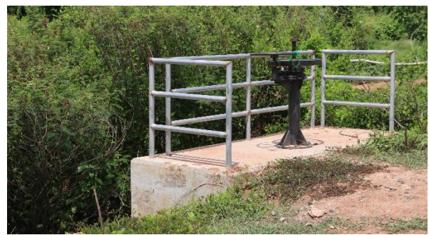
ภาพที่ 1.2.4 ประตูเปิด-ปิดน้ำ อ่างเก็บน้ำหนองปรือ
