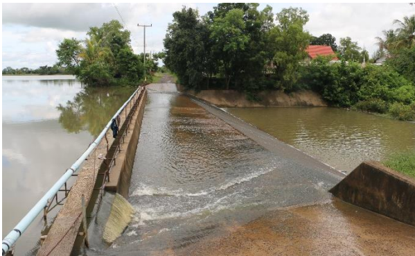
ภาพที่ 1.4.3 ฝายน้ำล้นจากอ่างเก็บน้ำ บ้านตารางค์ด้านท้ายอ่าง
