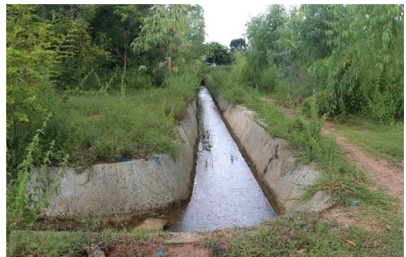
ภาพที่ 1.4.6 มีคลองส่งน้ำแบบคอนกรีต
