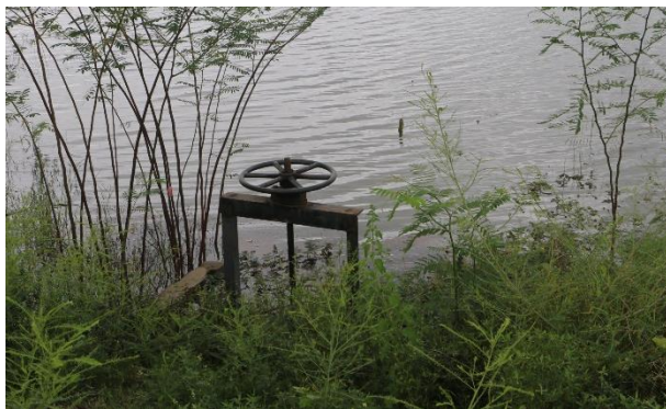
ภาพที่ 1.4.5 ประตูเปิด-ปิดน้ำ อ่างเก็บน้ำ บ้านตารางค์
