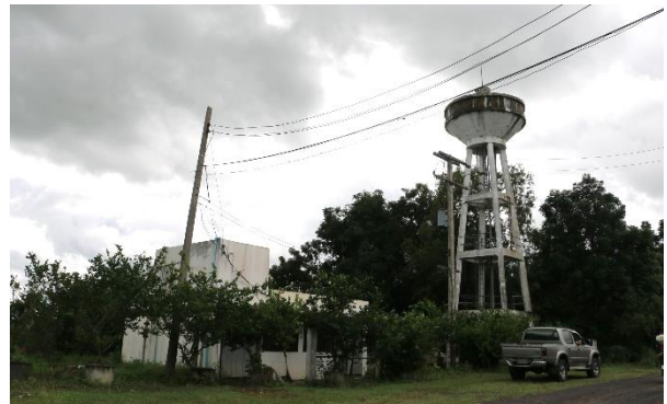
ภาพที่ 1.4.4 มีการสูบน้ำจากอ่างเพื่อทำประปา ชุมชน
