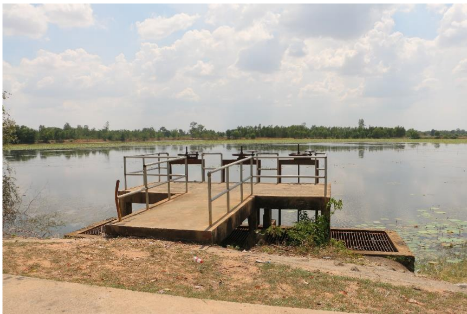
ภาพที่ 1.5.4 มีประตูเปิดปิดน้ำ และฝายน้ำล้น(อาคารประกอบ) สภาพใช้งานได้
