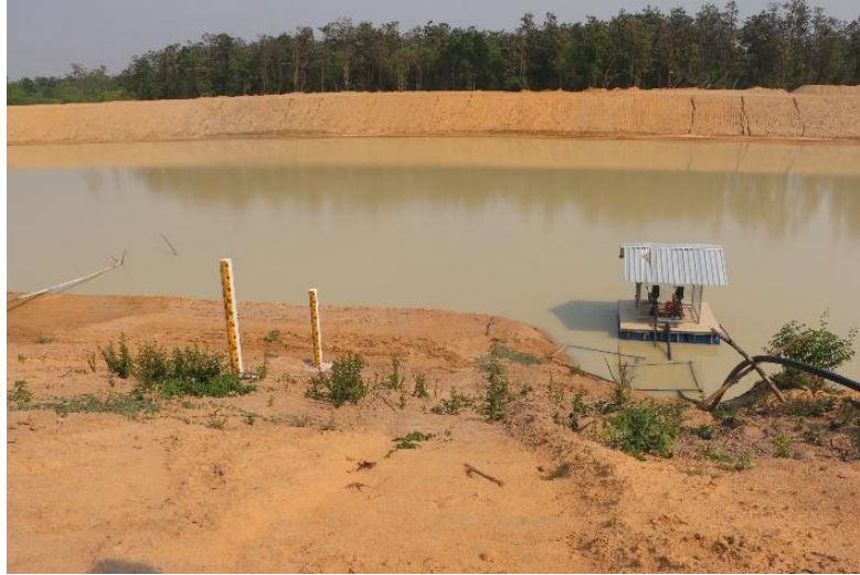
ภาพที่ 1.7.4 มีการสูบน้ำจากอ่างเพื่อทำประปาใช้ในฟาร์มตัวอย่างบ้านกระเจา
