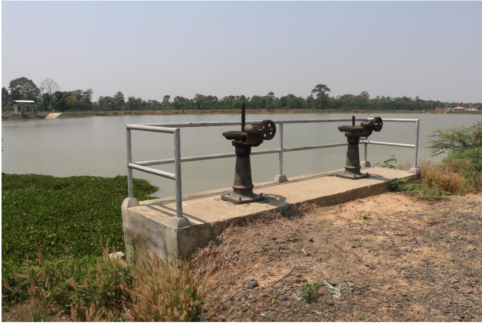
ภาพที่ 3.1.3 มีประตูเปิด-ปิดน้ำ สภาพใช้งานได้ปกติ
