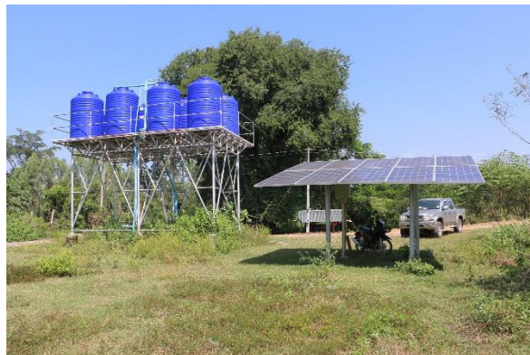
ภาพที่ 4.1.3-4.1.5 มีระบบลำเหมือง และคลองส่งน้ำแบบคลองดิน และระบบสูบน้ำ พลังงานแสงอาทิตย์
