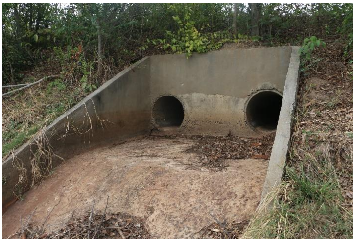
ภาพที่ 5.4.3 มีท่อน้ำเข้าสำหรับรับน้ำหลากจากบริเวณรอบ ๆ
