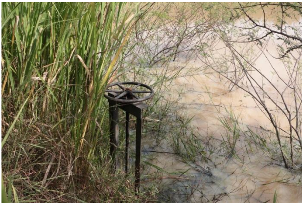
ภาพที่ 6.7.5 ประตูเปิด-ปิดน้ำ อ่างเก็บน้ำซับคะนิง
