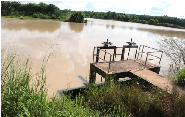
ภาพที่ 6.7.3-6.7.4 ฝายน้ำล้นจากอ่างเก็บน้ำซับคะนิงด้านท้ายอ่าง เพื่อปล่อยน้ำไปยังลำน้ำเดิม
