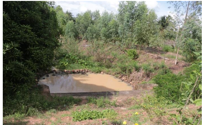
ภาพที่ 6.7.3-6.7.4 ฝายน้ำล้นจากอ่างเก็บน้ำซับคะนิงด้านท้ายอ่าง เพื่อปล่อยน้ำไปยังลำน้ำเดิม
