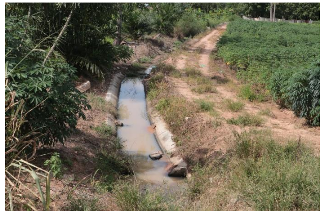
ภาพที่ 6.7.6 มีคลองส่งน้ำแบบคอนกรีต
