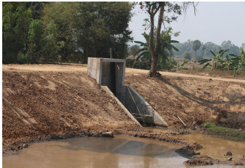
ภาพที่ 6.9.5 ทางน้ำเข้าฝ่ายบ้านฝรั่ง ซึ่งอยู่ระหว่างการก่อสร้าง
