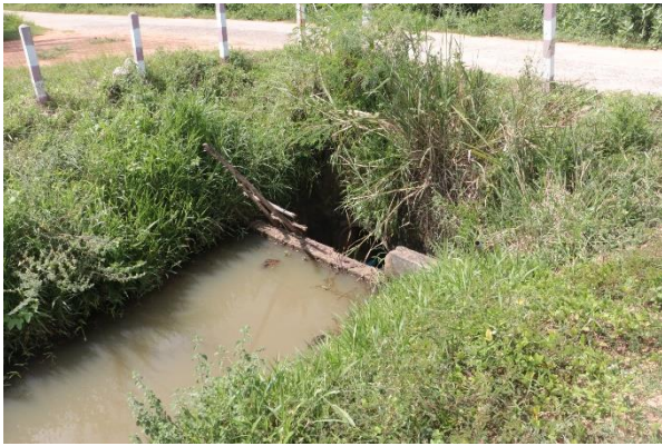
ภาพที่ 6.11.3-6.11.4 มีระบบน้ำล้น และคลองส่งน้ำแบบคลองดินสภาพปัจจุบัน ค่อนข้างรกรทึบ
