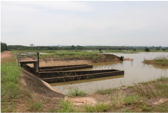
ภาพที่ 6.12.3 ฝายน้ำล้นจากอ่างเก็บน้ำบ้านโคกเพชร ด้านท้ายอ่าง
