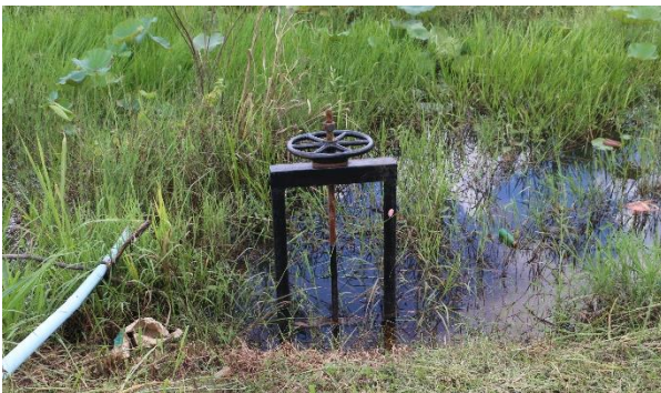
ภาพที่ 6.13.5 ประตูเปิด-ปิดน้ำ อ่างเก็บน้ำ คลองหิน
