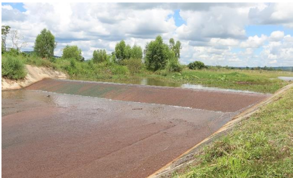
ภาพที่ 6.13.3 ฝายน้ำล้นจากอ่างเก็บน้ำบ้านคลองหิน ด้านท้ายอ่าง
