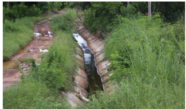
ภาพที่ 6.13.6 มีคลองส่งน้ำแบบคอนกรีต
