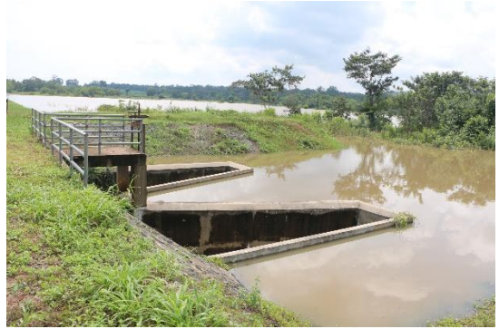
ภาพที่ 6.14.3-6.14.4 ฝายน้ำล้นจากอ่างเก็บน้ำคลองยาง ด้านท้ายอ่าง
