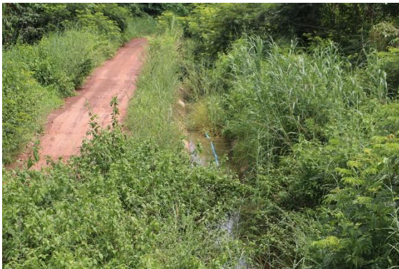
ภาพที่ 6.14.5 มีคลองส่งน้ำแบบคอนกรีต
