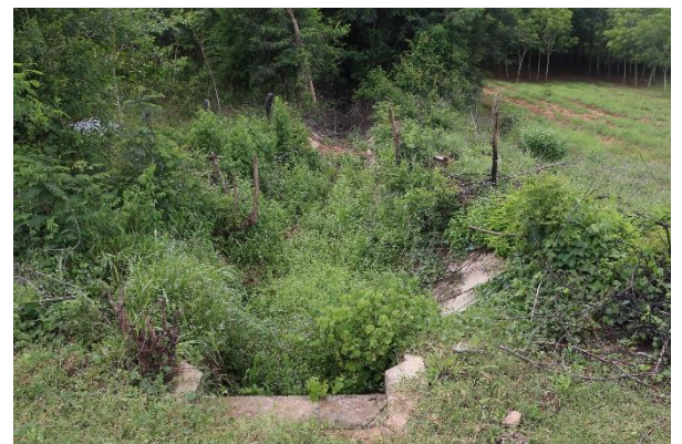
ภาพที่ 6.15.6 มีคลองส่งน้ำแบบคอนกรีต สภาพมีวัชพืชปกคลุม
