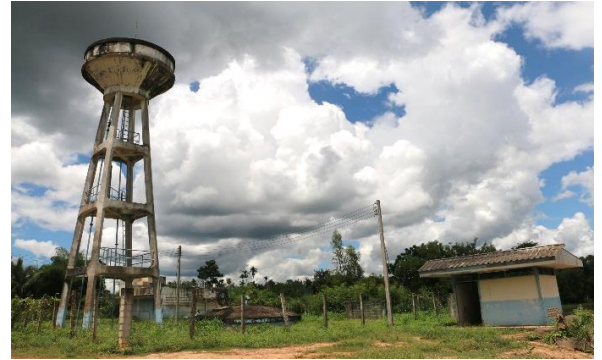
ภาพที่ 6.15.4 มีการสูบน้ำจากอ่างเพื่อทำ ประปาชุมชน
