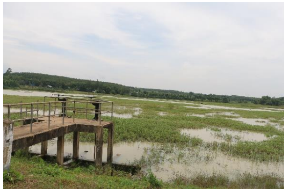
ภาพที่ 6.16.3 ฝ่ายน้ำล้นจากอ่างเก็บน้ำ บ้านฐานเจ้าป่าด้านท้ายอ่าง
