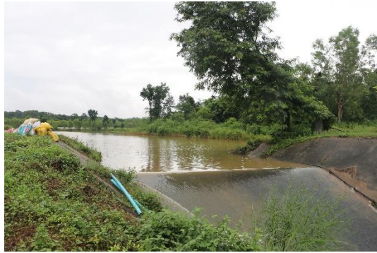
ภาพที่ 6.17.3 ฝายน้ำล้นจากอ่างเก็บน้ำ ป่าไม้สहरณ์ ด้านท้ายอ่าง
