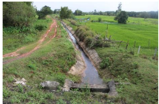
ภาพที่ 6.21.6 มีคลองส่งน้ำแบบคอนกรีต
