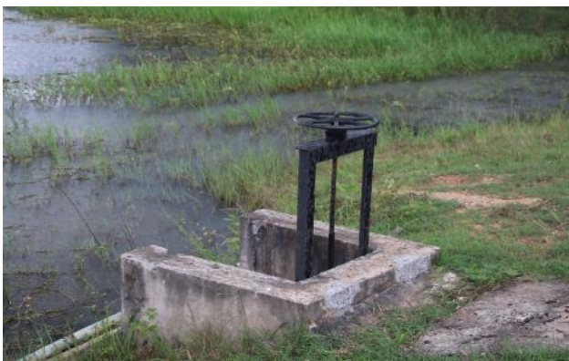
ภาพที่ 6.21.5 ประตูเปิด-ปิดน้ำ อ่างเก็บน้ำคลองโป่ง
