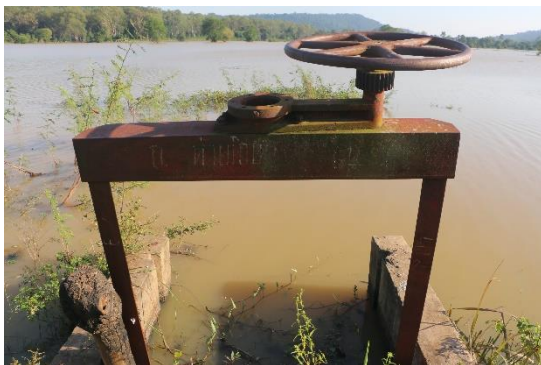
ภาพที่ 7.1.5 ประตูเปิด-ปิดน้ำ มีสภาพชำรุด
