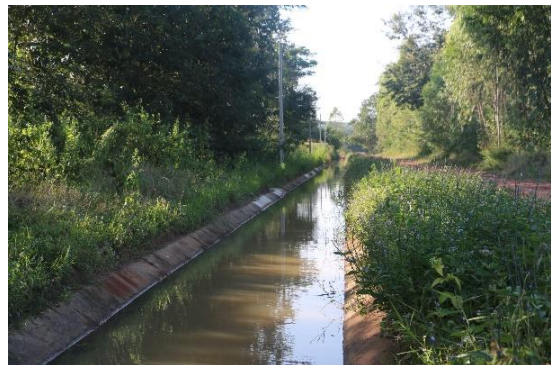
ภาพที่ 7.1.6 มีคลองส่งน้ำแบบคอนกรีต
