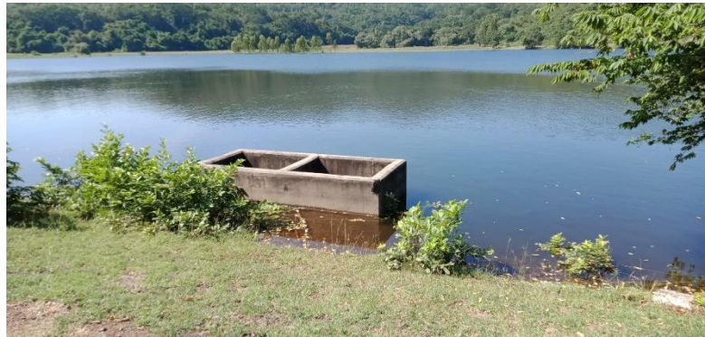
ภาพที่ 9.1.3 ฝายน้ำล้นจากอ่างเก็บน้ำคลองปูน ด้านท้ายอ่าง
