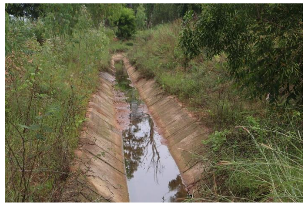
ภาพที่ 10.1.3-10.1.4 มีระบบส่งน้ำแบบคลองคอนกรีต สภาพใช้งานปกติ
