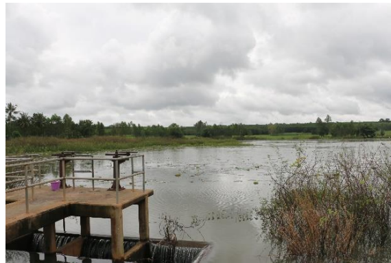
ภาพที่ 13.2.3-13.2.4 ฝายน้ำล้นจากอ่างเก็บน้ำสันติสุขด้านท้ายอ่าง
