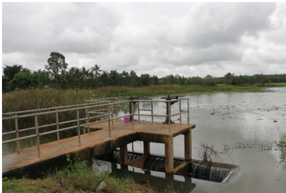
ภาพที่ 13.2.3-13.2.4 ฝายน้ำล้นจากอ่างเก็บน้ำสันติสุขด้านท้ายอ่าง
