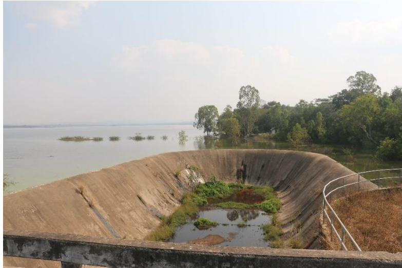
ภาพที่ 13.3.4 ฝ่ายน้ำล้นอ่างเก็บน้ำลำจังหัน
