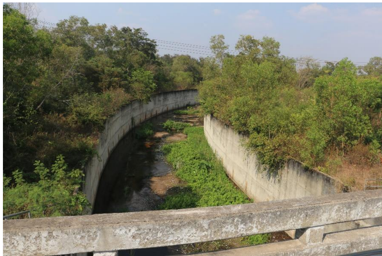
ภาพที่ 13.3.6 คลองส่งน้ำอ่างเก็บน้ำลำจังหัน
