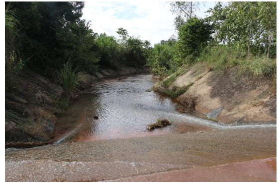
ภาพที่ 13.4.3-13.4.4 ฝายน้ำล้นจากอ่างเก็บน้ำเป็ยมพะยิว ด้านท้ายอ่าง
