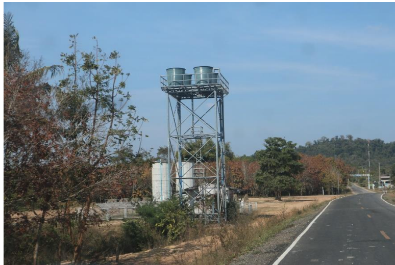
ภาพที่ 13.5.8 ประปาซึ่งใช้น้ำจากอ่างเก็บน้ำห้วยนาเหนือ
