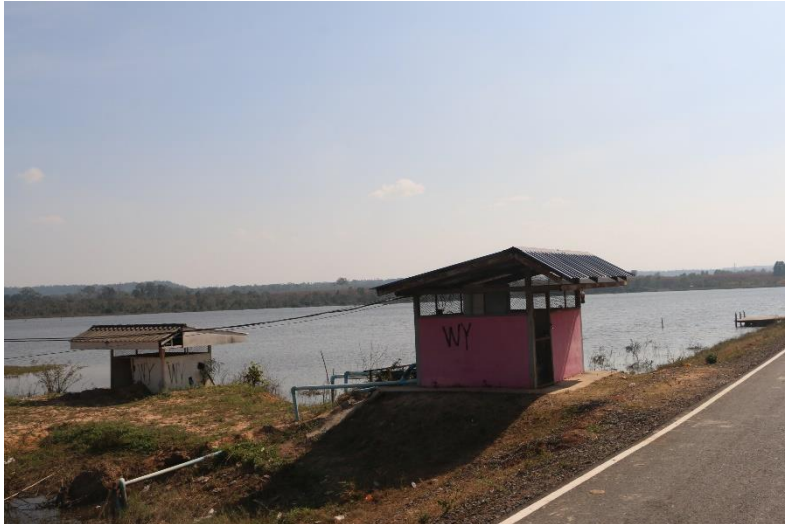
ภาพที่ 13.5.7 สถานีสูบน้ำอ่างเก็บน้ำห้วยนาเหนือ 2 สถานี
