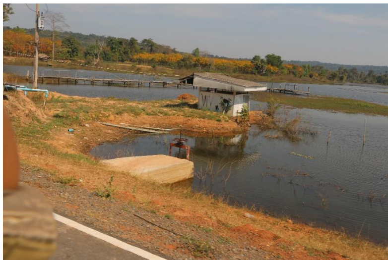
ภาพที่ 13.5.6 สถานีสูบน้ำอ่างเก็บน้ำห้วยนาเหนือ
