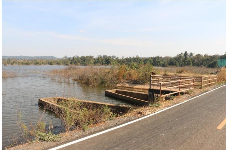
ภาพที่ 13.5.4 ฝ่ายน้ำล้นอ่างเก็บน้ำห้วยนาเหนือ
