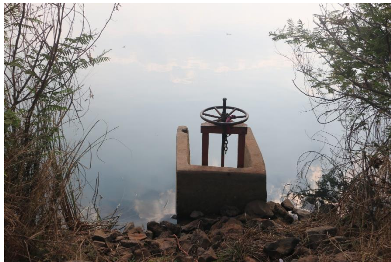
ภาพที่ 13.6.3 อ่างเก็บน้ำร่องน้ำซับ มีประตูเปิด - ปิดน้ำ
