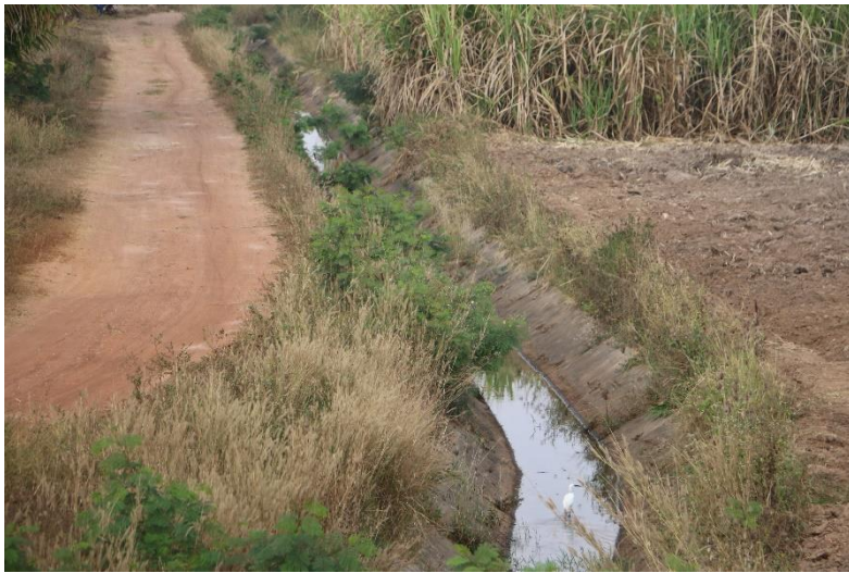
ภาพที่ 13.6.5 คลองส่งน้ำจากอ่างเก็บน้ำร่องน้ำชัย
