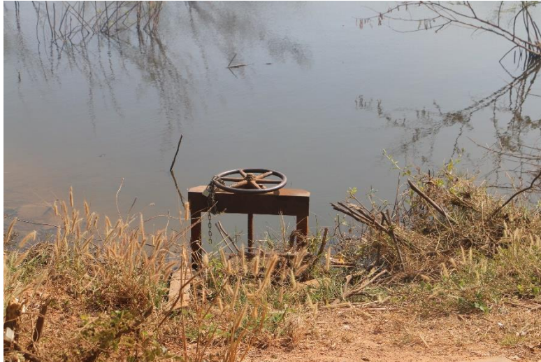
ภาพที่ 13.7.4 ประตูเปิด - ปิดน้ำ อ่างเก็บน้ำห้วยดินทราย
