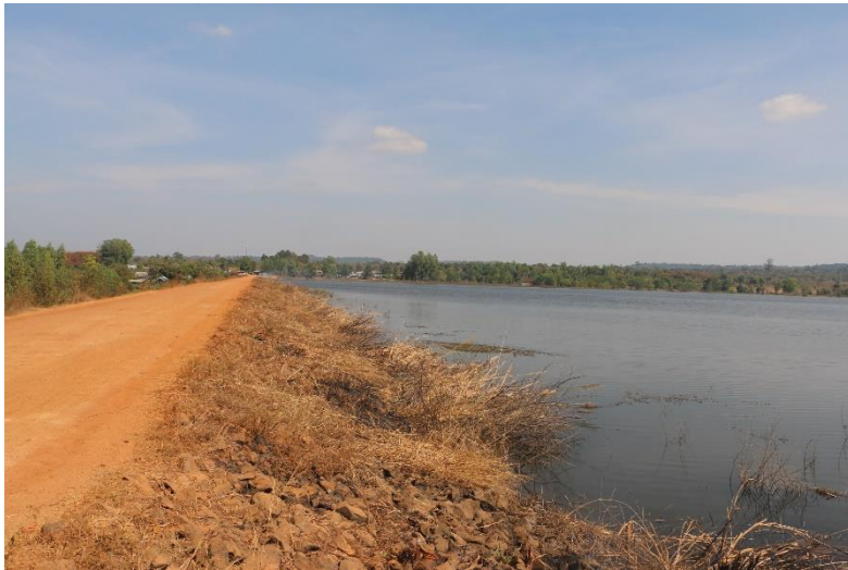
ภาพที่ 13.7.2 อ่างเก็บน้ำห้วยดินทราย มีสภาพต้นเขิน
