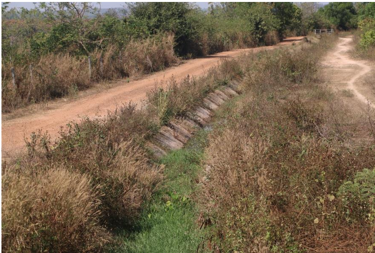
ภาพที่ 13.7.5 คลองส่งน้ำคอนกรีตเสริมเหล็ก อ่างเก็บน้ำห้วยดินทราย
