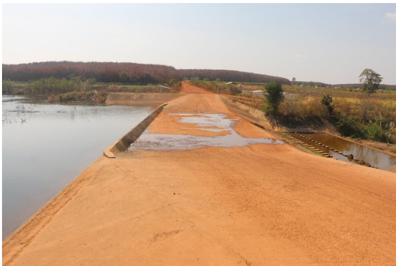
ภาพที่ 13.7.3 บริเวณฝายน้ำล้นอ่างเก็บน้ำห้วยดินทราย
