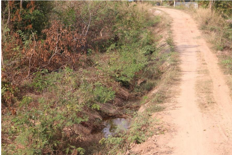
ภาพที่ 13.8.4 คลองส่งน้ำคอนกรีตเสริมเหล็ก อ่างเก็บน้ำต้นลำปะเทีย
