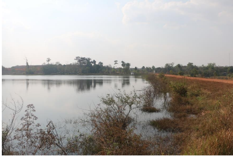
ภาพที่ 13.8.1 อ่างเก็บน้ำต้นลำปะเทีย มีปริมาณน้ำ 80 เปอร์เซ็นต์ของความจุอ่าง และมีสภาพตื้นเขิน
