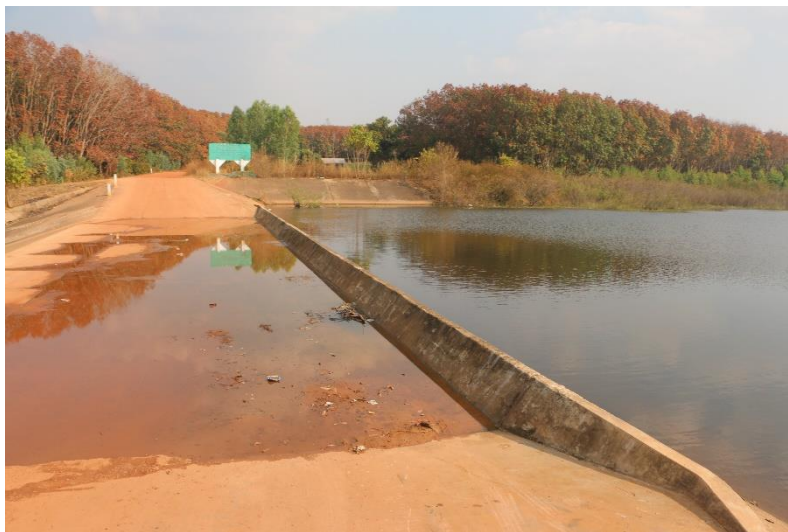
ภาพที่ 13.8.3 ฝายน้ำล้นอ่างเก็บน้ำต้นลำปะเทีย
