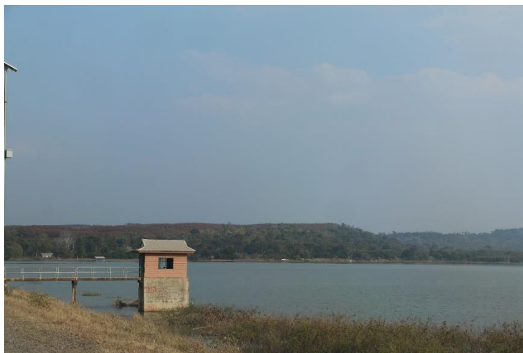
ภาพที่ 13.9.3 อาคารบังคับน้ำอ่างเก็บน้ำลำปะเทีย
