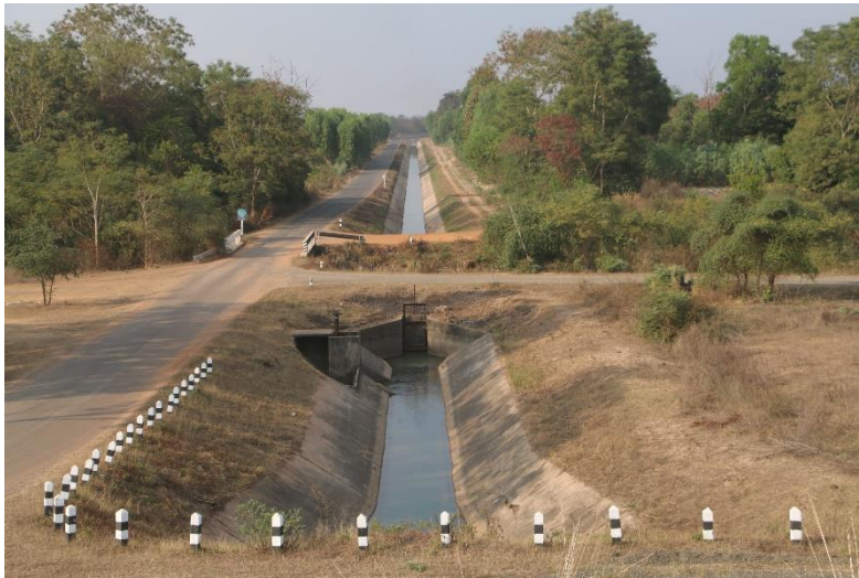
ภาพที่ 13.9.5 คลองส่งน้ำคอนกรีตเสริมเหล็ก อ่างเก็บน้ำลำปะเทีย
