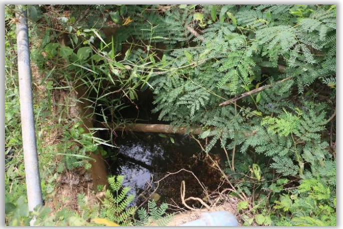
ภาพที่ 13.11.3-13.11.4 มีระบบน้ำล้น และคลองส่งน้ำแบบคลองดินสภาพปัจจุบันค่อนข้างรกทึบ
