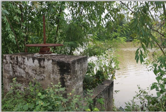
ภาพที่ 13.11.3-13.11.4 มีระบบน้ำล้น และคลองส่งน้ำแบบคลองดินสภาพปัจจุบันค่อนข้างรกทึบ
