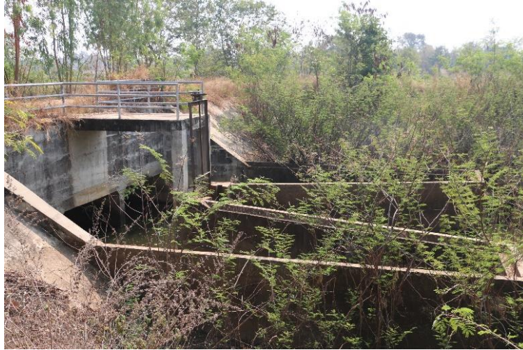
ภาพที่ 14.1.4 สภาพฝายปัจจุบันใช้งานได้ปกติ
