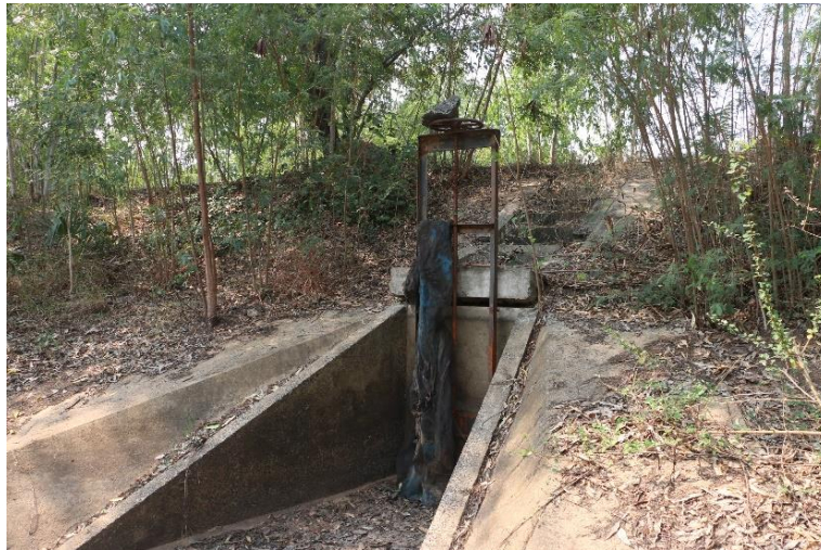
ภาพที่ 14.1.5 ประตูเปิด-ปิดน้ำ สภาพใช้งานได้
