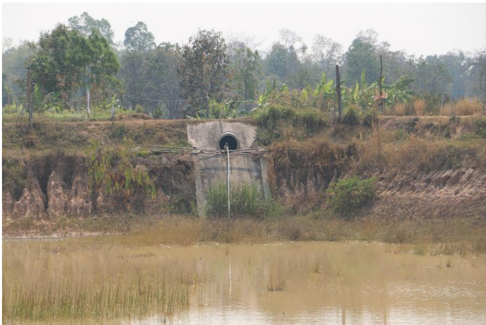
ภาพที่ 14.3.3-14.3.4 มีระบบน้ำเข้าเป็นท่อสำหรับรับน้ำหลากจากบริเวณรอบ ๆ
