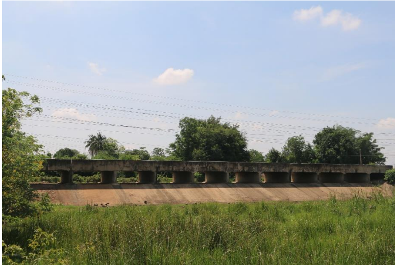
ภาพที่ 16.1.1 ฝ่ายบ้านโคกเหล็ก ปัจจุบันสภาพใช้งานได้ปกติ
