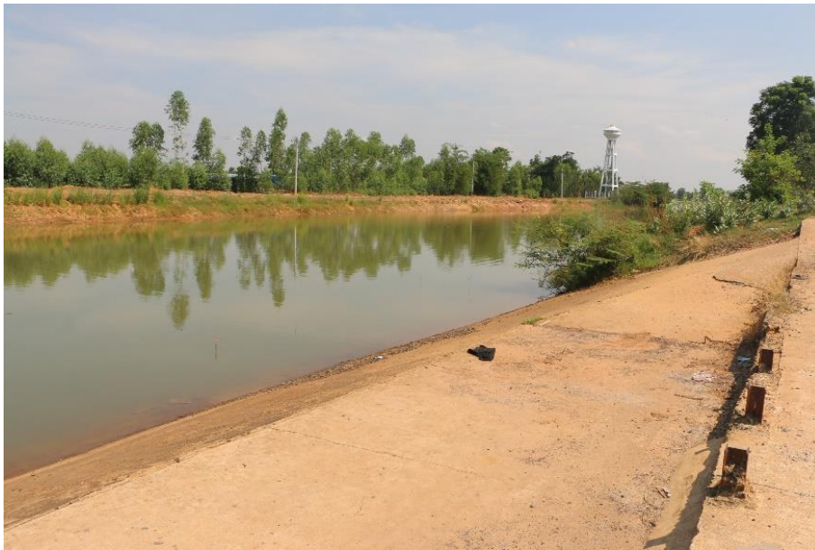
ภาพที่ 16.2.2 มีฝายน้ำล้นคอนกรีตเสริมเหล็ก สภาพใช้งานได้
