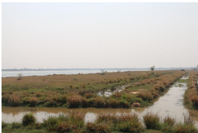
ภาพที่ 14.4.3 คลองรับน้ำบริเวณอ่างเก็บน้ำทุ่งใหญ่
