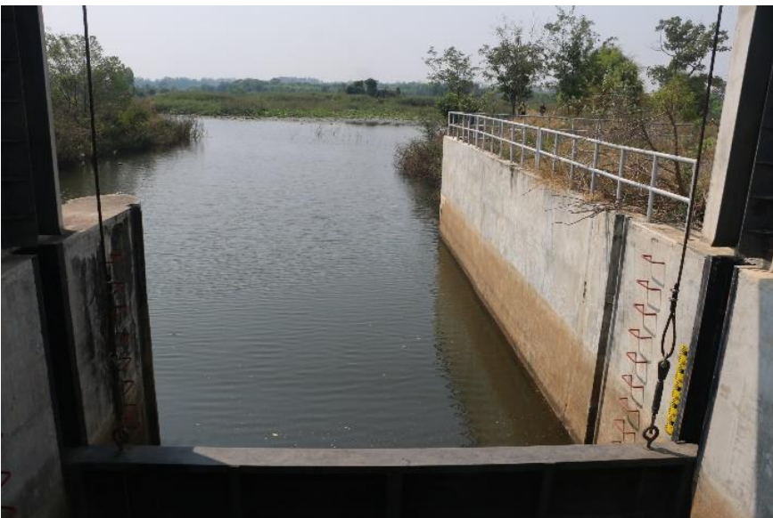
ภาพที่ 14.5.1-14.5.3 อาคารระบายน้ำฝายบ้านหนองโดน สภาพใช้งานได้ปกติ
