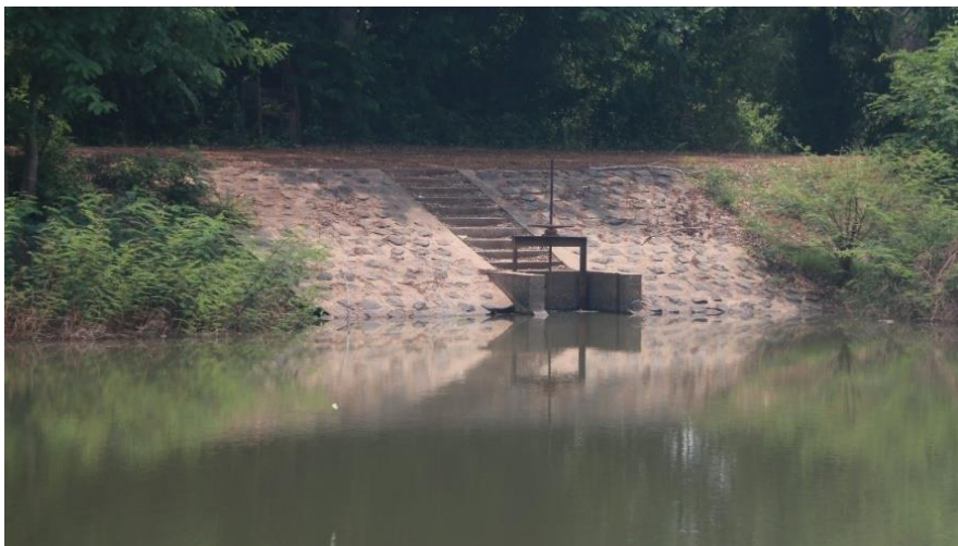
ภาพที่ 4.3.2 ประตูเปิด - ปิดน้ำ ฝายบ้านเสลา
