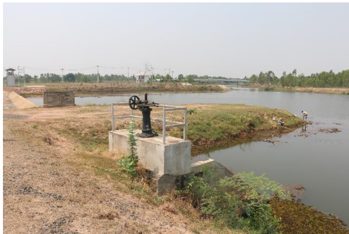
ภาพที่ 8.1.3 มีประตูเปิด-ปิดน้ำ สภาพใช้งานได้
