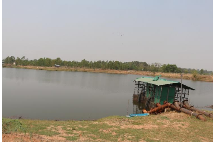
ภาพที่ 8.1.4 มีเครื่องสูบน้ำใช้ในการผลิตประปาชุมชน
